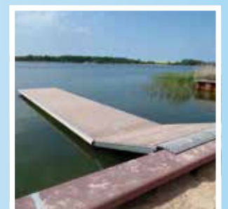
Steganlage Wolgast (M.V.)
